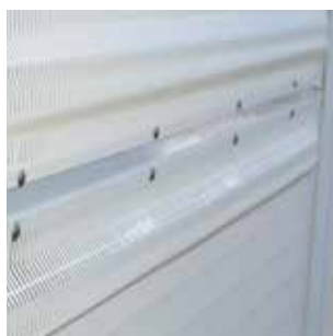
Extérieur du site
