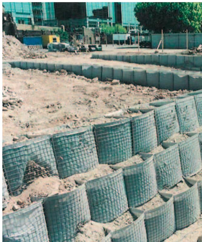
Les bastions Weldmesh® Betafence sont habillés en usine d'une membrane géotextile non tissée qui vient tapisser toute la surface intérieure des panneaux composants la cage, ce qui permet d'utiliser les granulats appropriés pour assurer un compactage optimal des matériaux et éviter tout tassement ultérieur.
