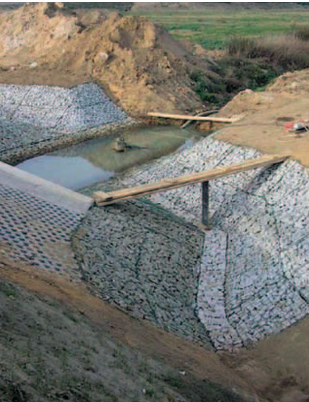
Les Matelas Weldmesh® sont préfabriqués à partir de treillis métallique en fils d'acier noués. Les matelas sont fabriqués avec des fils d'acier de diamètre plus fin pour leur assurer une bonne flexibilité. Ils servent à la protection des berges, du littoral et à la réalisation de lits pour les cours d'eau, les canaux ou les chenaux.
