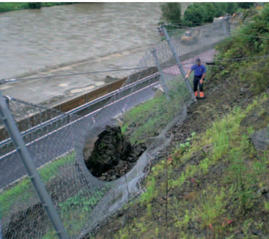
Les systèmes de protection contre les chutes de pierres ou les clôtures de captage servent de protection secondaire contre les chutes ou les glissements de roches dans les zones d'éboulement ou les zones de dépôt potentielles. Ils sont utilisés pour la protection des zones habitées et des infrastructures.
