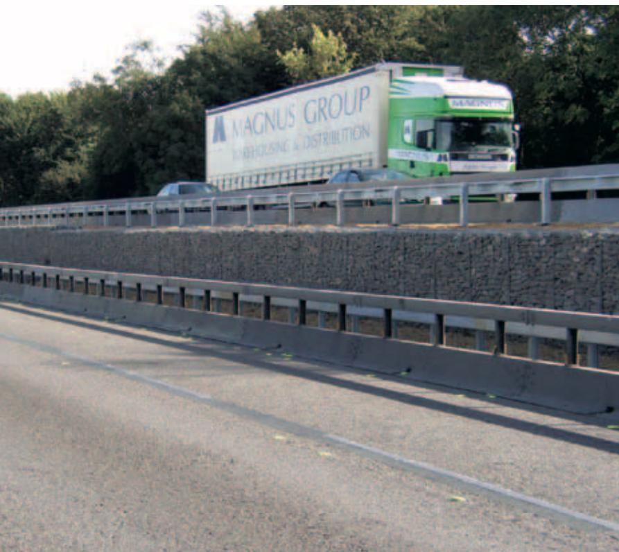
Les gabions Weldmesh® Betafence sont des paniers en treillis métallique, constitués de panneaux individuels soudés et assemblés entre eux par des spirales hélicoïdales placées sur les fils formant les arêtes verticales.
