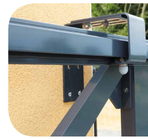
Système de guidage du vantail
