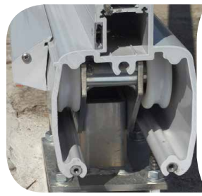
Roues porteuses intégrées dans la poutre
